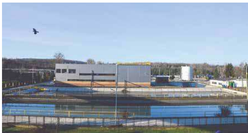
Budynek SUW za zbiornikami wody surowej (woda dołowa zmieszana z wodami opadowymi), po prawej stronie zbiornik wody przeciwpożarowej (550 m 3 ).
